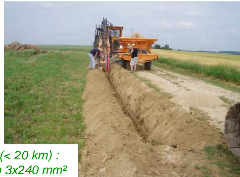
Enfouissement câbles : 0,5 à 1 m de profondeur
