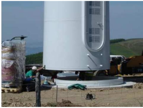
Assemblage des tronçons de mât
