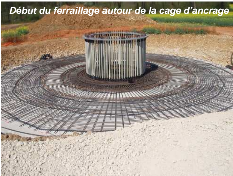
Cage d'ancrage servant de virole
