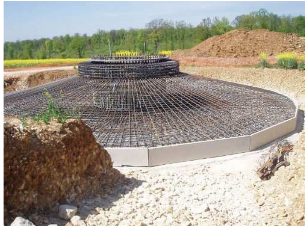
Cage d'ancrage servant de virole
